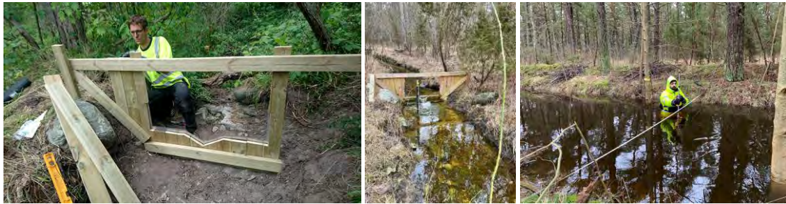
Figur 2a och 2b Installation av flödesmätutrustning vid MY3 och 2c/ kalibrering för flödesmätare i det större Petesdiket (som dock ej omfattas av denna MKB). Placering av realtidssystemets infrastruktur framgår av kartan, markerade med A.
