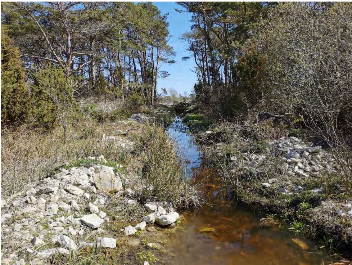
Foto 25. Foto från objekt nr 18. Ett tillrinningsdike i södra änden.
