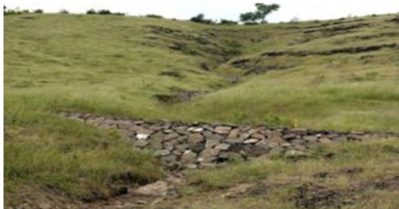
Figur 3a och 3b. Hinder i diken för att stimulera grundvattenbildning i Ralegan Siddhi och Rupali Deskmuth vid blottlagt grundvatten i tidigare sandtag vid Vamlingbo, Storsudret.
